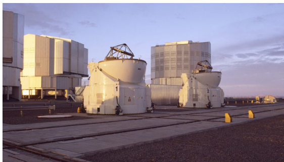
Figur 12. To af de mindre teleskoper på 1,8 m som kan indgå i observation med de store 8,2 m VLT teleskoper (ESO).
