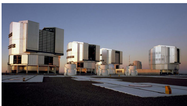
Figur 2. Very Large Telescope består af fire teleskoper på hver 8,2 m (diameter). De fire teleskoper er forbundet med hinanden via en serie underjordiske tunneller, som samtidigt forbinder dem med en række mindre teleskoper (ESO).
